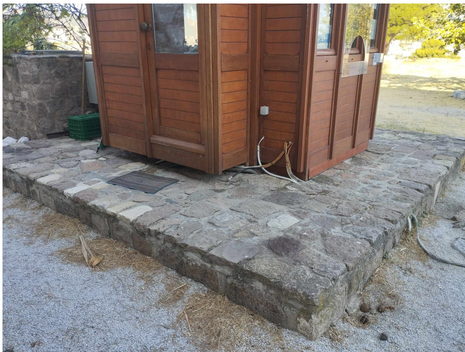
Εικόνα 1: Υπάρχουσα βάση φυλακίου με λίθινη επένδυση
