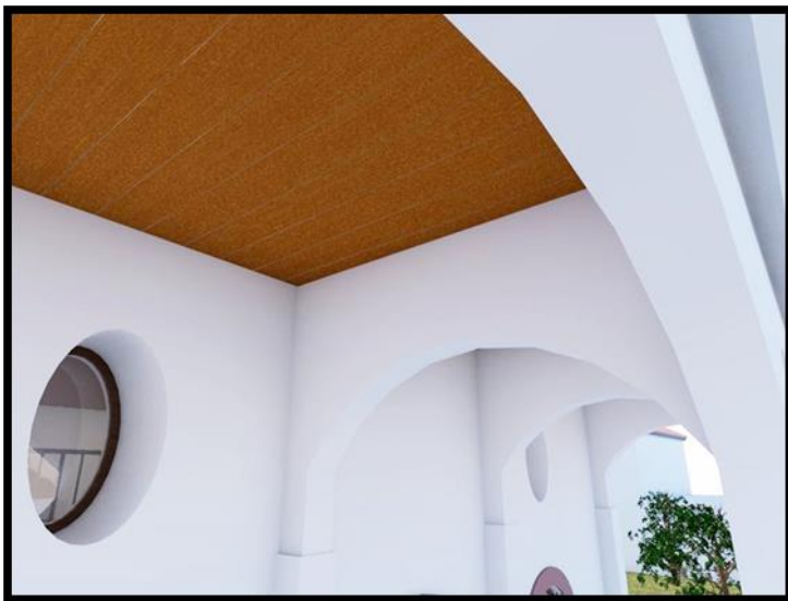
Εικόνα 3 – Οροφή προστώου (εξωνάρθηκα) από ξύλινες τάβλες
